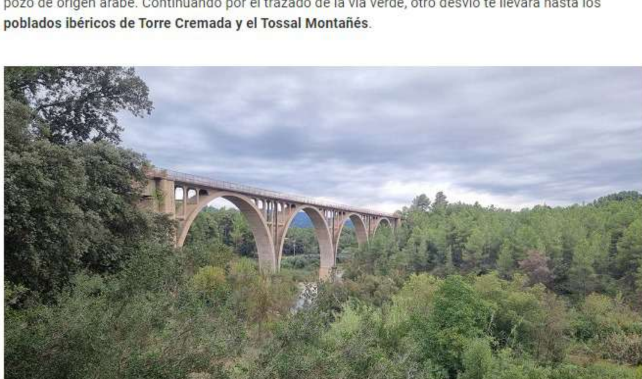
Viaducto Río Matarraña./ L.C.
