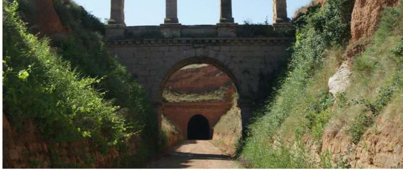
Puente de La Torica en La Puebla de Híjar./ L.C.
